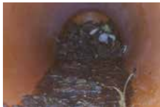
Imagen de una tubería durante la inspección.
